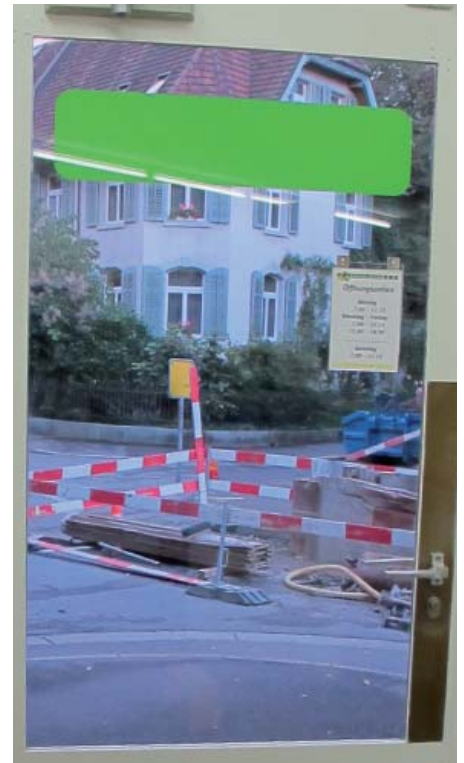
Baustelle direkt vor der Ladentür. Bild: Katrin Jenny
