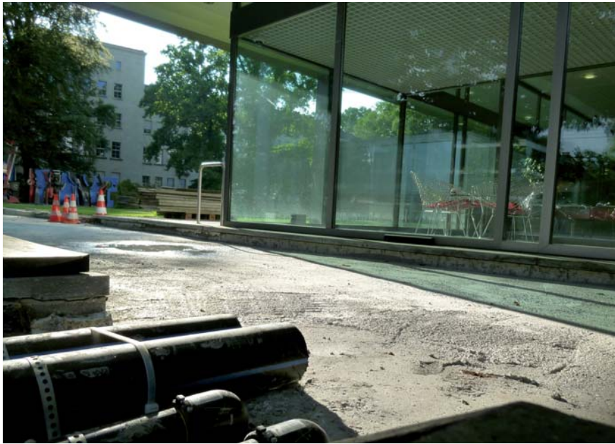
Etwas weniger tief als früher wird der neue Betonteich auf dem Versicherungsareal. Bild: mf
