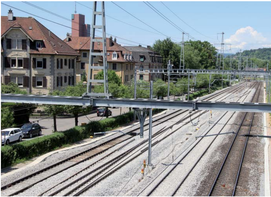
Bei Tageslicht sieht man die Baufortschritte der langgezogenen Spurwechsel. Bild: Peter Lehmann
