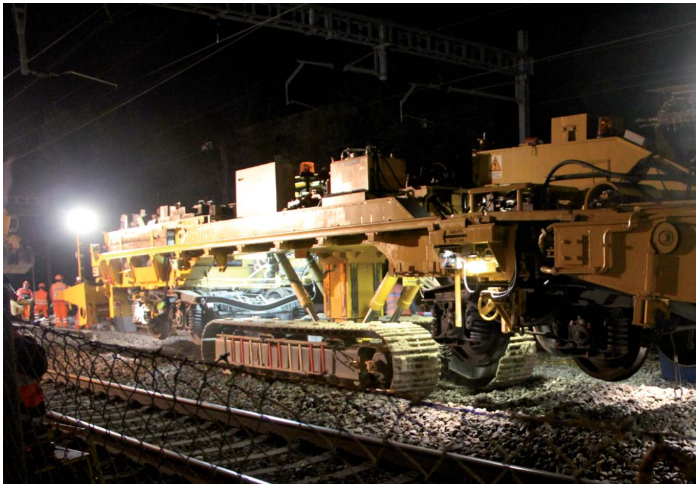
Nächtliches Schauspiel im Inneren Lind: Der Zug entfernt die Schienen, auf denen er steht – und fährt auf Raupen weiter.
