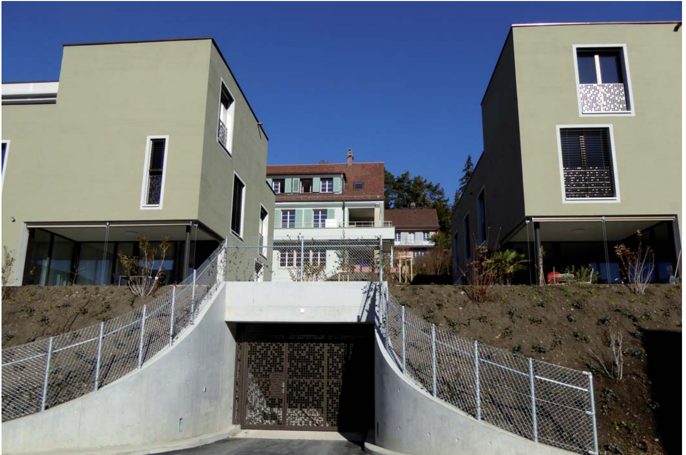
Im Garten der Villa «Reinhart-Ganzoni» an der Leimeneggstrasse sind zwei Doppel-Einfamilienhäuser erstellt worden.
