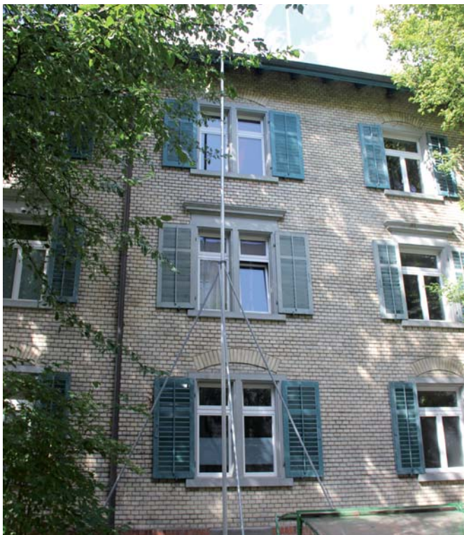
An der Sulzbergstrasse soll ein quertypisches Backsteinhaus einer sechsgeschossigen Bebauung mit maximaler Ausnutzung weichen. Bild: Peter Lehmann
