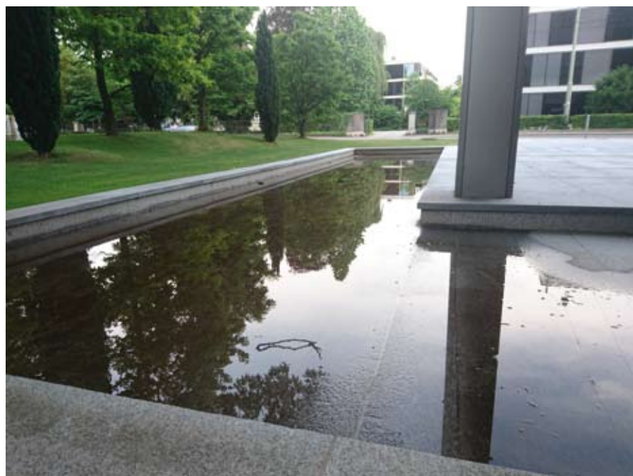
Nur das Regenwasser sammelt sich manchmal einige Tage im Betonbecken der Axa. Bild: mf
